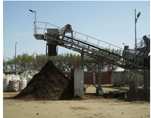
Photo 4 : Criblage final sur l'usine Abis 1, Alexandrie, Egypte
