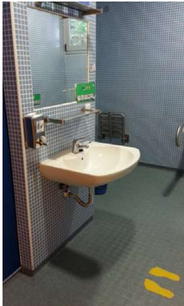
Figura 17: En este caso las pisadas definen el lugar de los pies para encontrar la posición correcta delante del espejo y la pileta para lavarse las manos, los dientes, etc.
