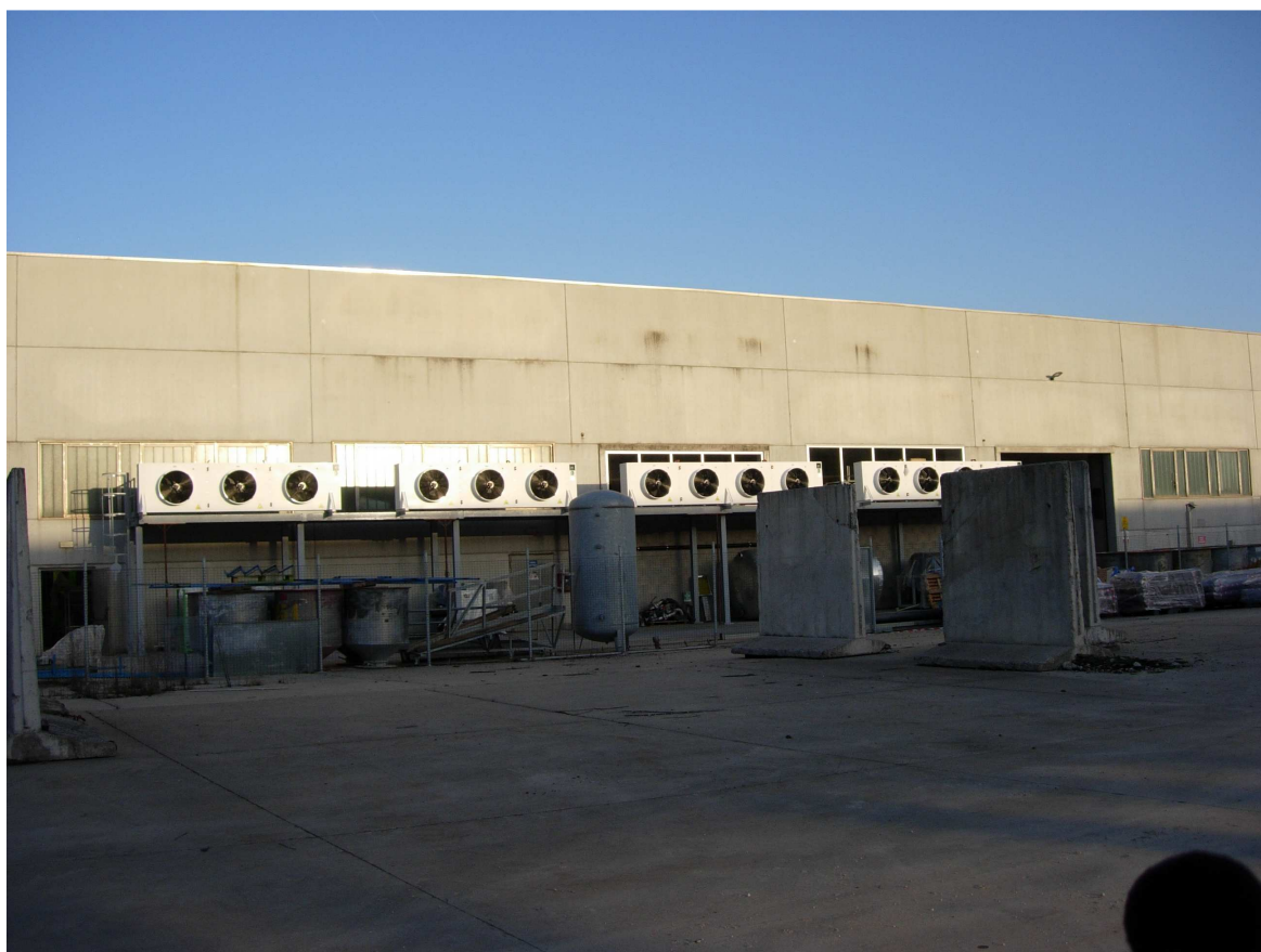
punto di misura in prossimità confine est
