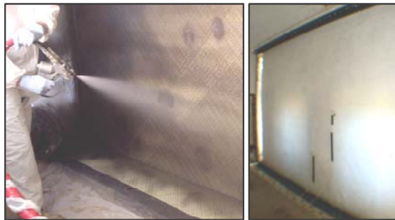
Fig. 8. R8- Polyurea spray 800 pli @ +/-45.
