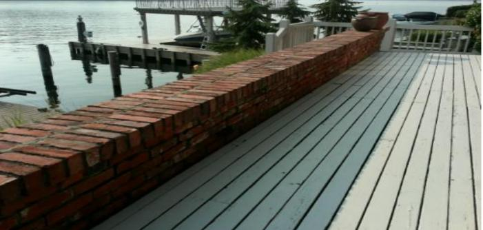
INSTALL A PROPER GUARD RAILING AT THE TOP OF THE BRICK WALL AT THE REAR DECK AREA AS IS REQUIRED BY LOCAL CODE STANDARDS FOR SAFETY.
