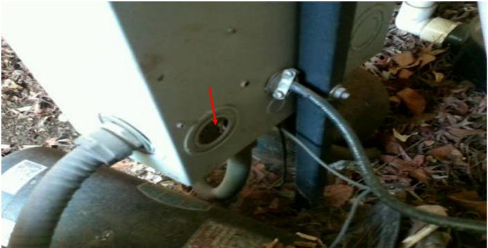
INSTALL PROPER BLOCK OUTS ON THE OPENING AT THE BACK OF THE SUB-PANEL AT THE HOT TUB EQUIPMENT AT THE NORTH SIDE OF THE HOUSE.
