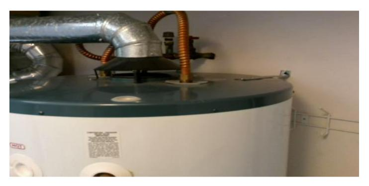
INSTALL PROPER EARTHQUAKE STRAPS AT THE TOP AND LOWER THIRD OF THE TANK AS REQUIRED TO SECURE THE HOT WATER TANK TO THE WALL FRAMING SYSTEM.
