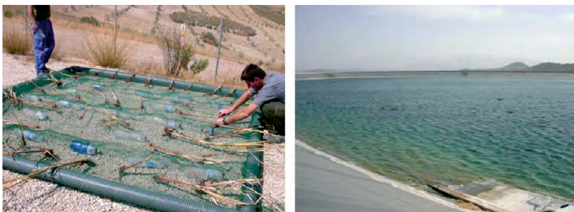
Instalación de islas con vegetación acuática en la balsa de Las Quebrás, Jódar. AMM
