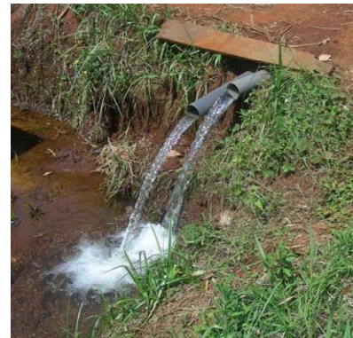
Évacuation de la dérivation du barrage
