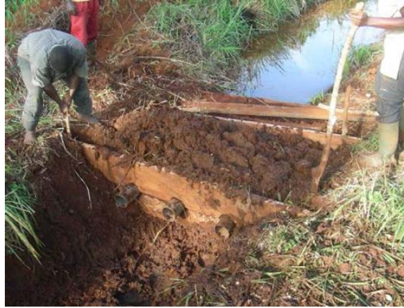
Remplissage de terre entre les planches
