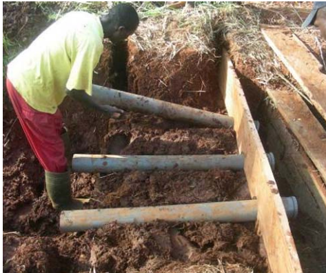
Tuyaux disposés dans le barrage
