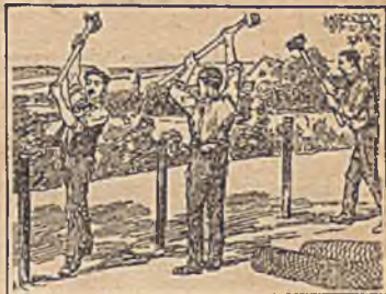
Les treillageurs enfonce des pieux.
