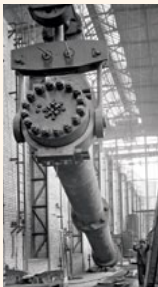
Ein Hochdruck-Reaktor wird 1921 in die Ammoniakfabrik eingebaut.
