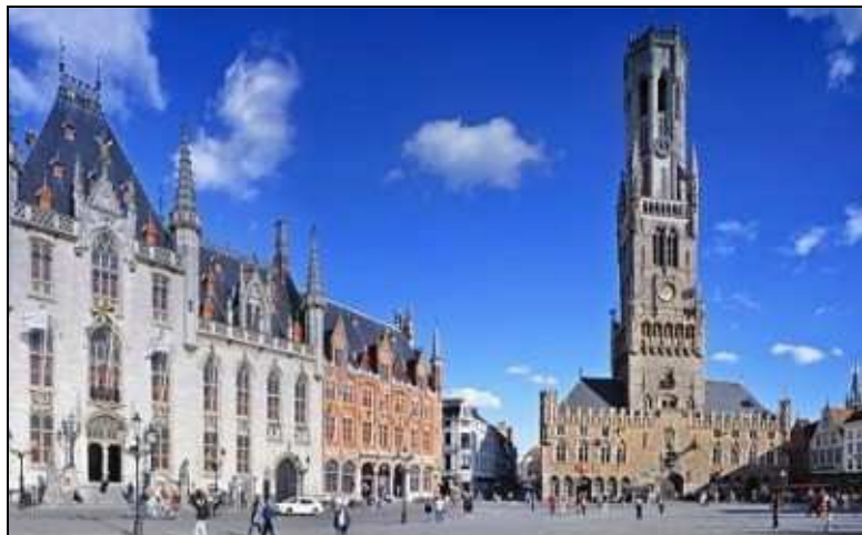
Foto actual Campanario y Plaza
