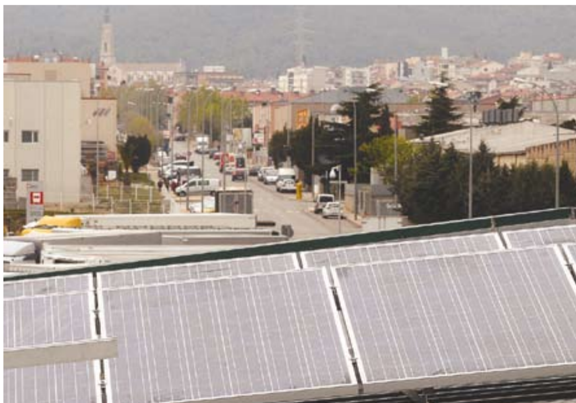
© Les cobertes de Via Pública, en la imatge, del Pavelló Puigvert i del Parc de Bombers acullen 92 plaques solars. || J.G.
