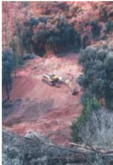
© Excavadora treballant al Ripoll. || L'A
