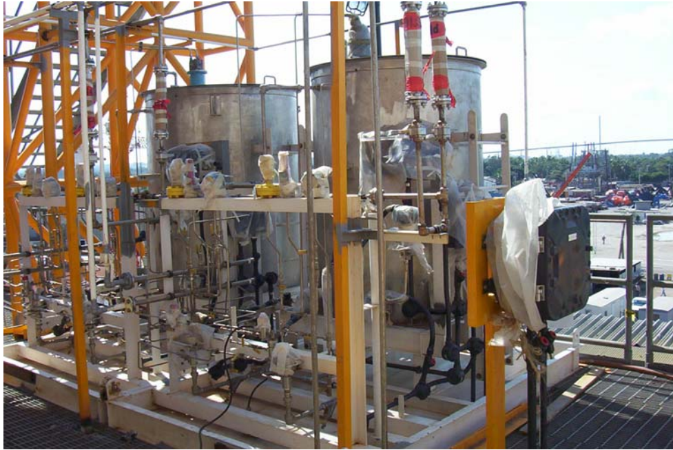
Sistemas de dosificación de antiespumante y anticrustante para la plataforma de producción KU-C de Petróleos Mexicanos División Exploración y Producción incluyendo bombas dosificadoras de accionamiento neumático marca Williams Milton Roy serie V fabricadas de acuerdo al código API-675 ( 2004 )
