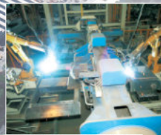
Đường hàn khung chính
