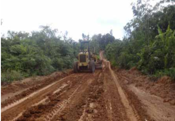
2. Grading Jalan Desa Dirung Sararong untuk RT I dan RT II
