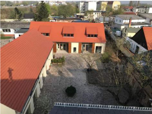
Foto: Jan Kretschmar, Eigentümer der Gehöftanlage
