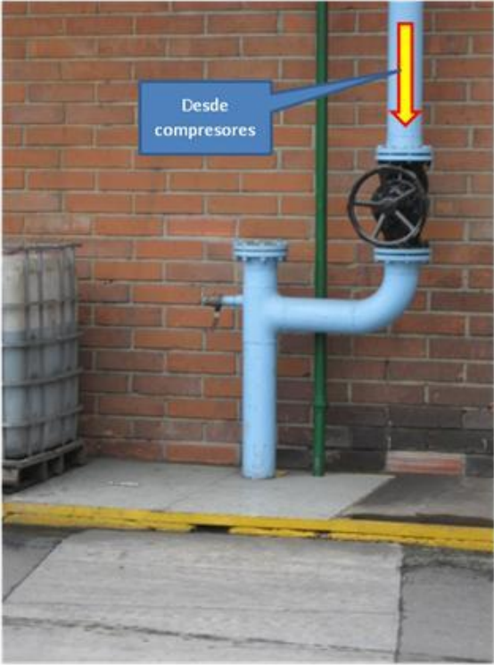
Fotografía 7. Comienzo del tramo enterrado, red de aire comprimido piezas plásticas.
