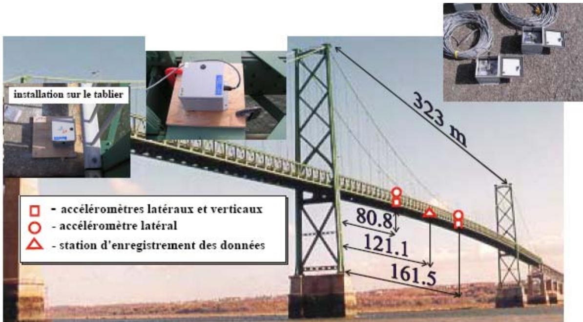
Figure 1: Vue générale du pont et installation de l'appareillage pour les tests in situ (octobre 2004).
