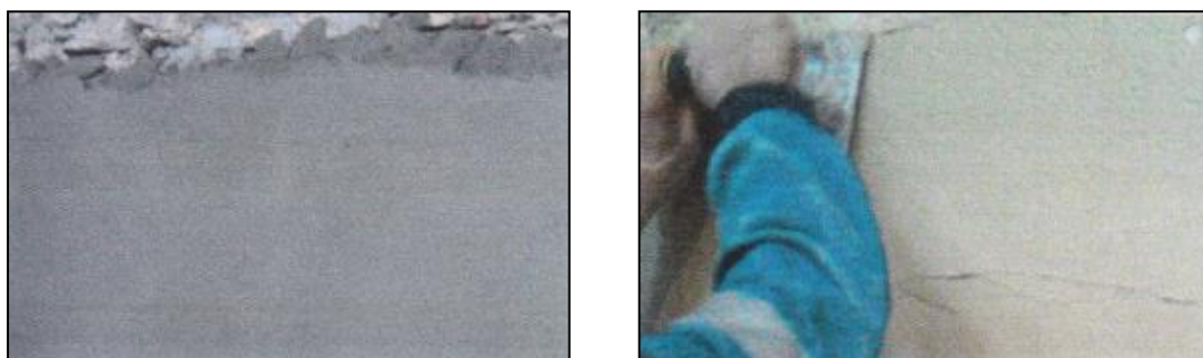
Figura 2.7 - Aplicação da argamassa de reboco [34].
