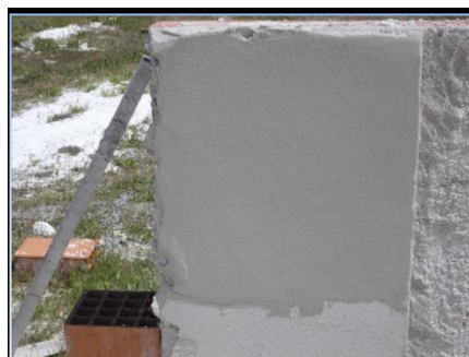
Figura 3.8 - Aplicação da camada de argamassa de acabamento.
