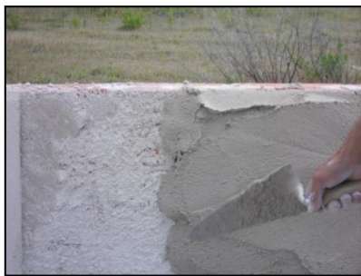
Figura 3.7 - Aplicação da camada de argamassa de reboco.
