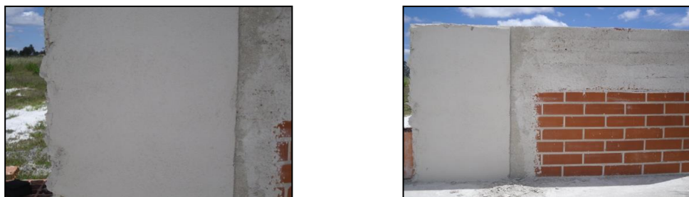
Figura 4.27 - Argamassas na parede de tijolo.
