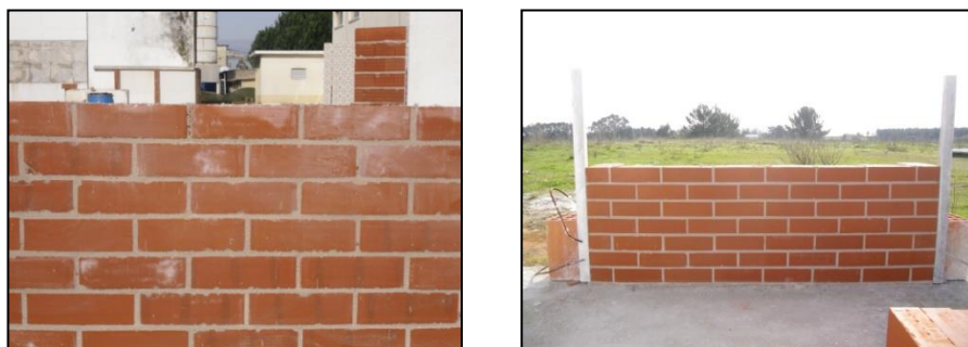
Figura 3.5 - Parede de tijolo com juntas de argamassa de consolidação.
