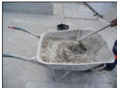
Figura 3.4 - Preparação da argamassa “in situ”.
