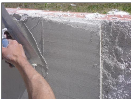
Figura 3.8 - Aplicação da camada de argamassa de acabamento.
