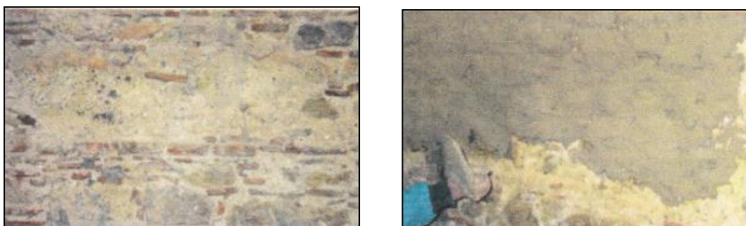
Figura 2.6 - Aplicação da argamassa de consolidação [18].
