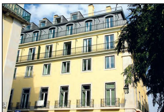
Figura 2.8 - Acabamento à base de cal na reabilitação de uma fachada antiga [35].
