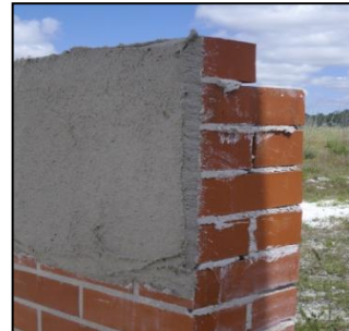
Figura 3.7 - Aplicação da camada de argamassa de reboco.
