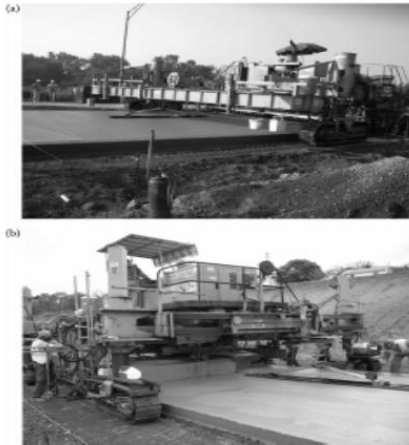
Gambar 22 - Mesin penghampar slipform
