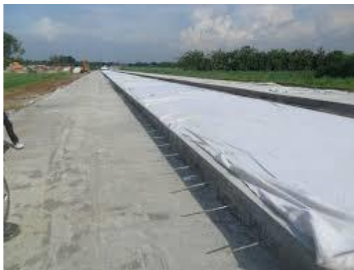
Gambar 19 - Sambungan pelaksanaan memanjang pada perkerasan bersambung tanpa tulangan
