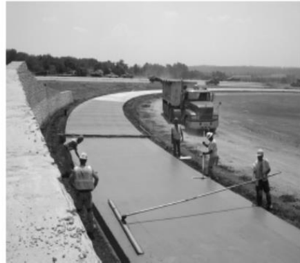
Gambar 23 - Penyelesaian akhir, hamparan dengan slipform didaerah tikungan
