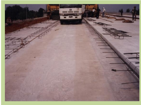
Gambar 8 - Kedudukan batang pengikat pada sambungan memanjang
