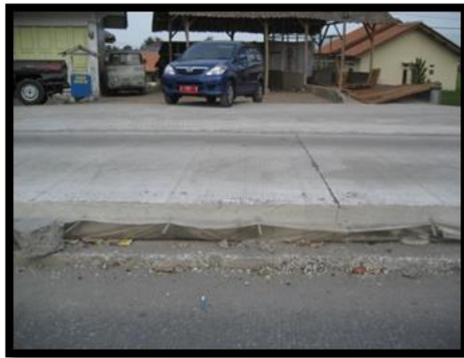
Gambar 24 – Lapis tambah sistem bonded
