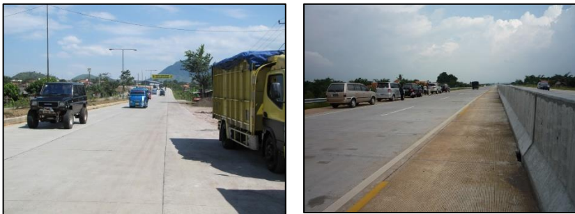
Gambar 4. Tipikal bahu beton pada perkeasan kaku
