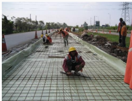
Gambar 10 - Perkerasan bersambung dengan tulangan
