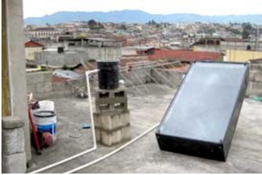
Figura 3. Calentador solar de agua CalSolAgua probado en Guatemala
