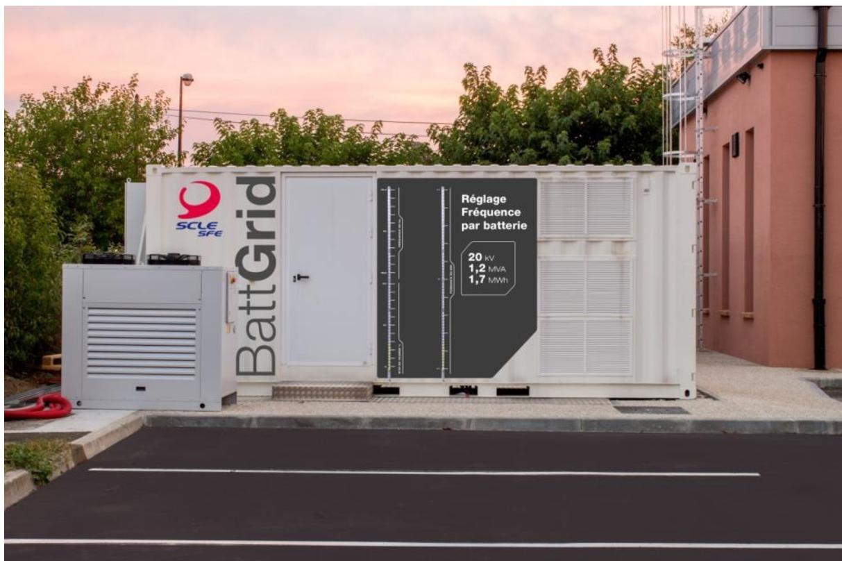
BattGrid™ est un système de stockage d'énergie par batterie lithium-ion d'une capacité de 1,5 MWh. Depuis septembre 2016, il fournit un service de Réglage fréquence pour RTE : le système est connecté au réseau de distribution d'électricité pour stocker l'énergie excédentaire et la réinjecter si nécessaire sur ce même réseau.
