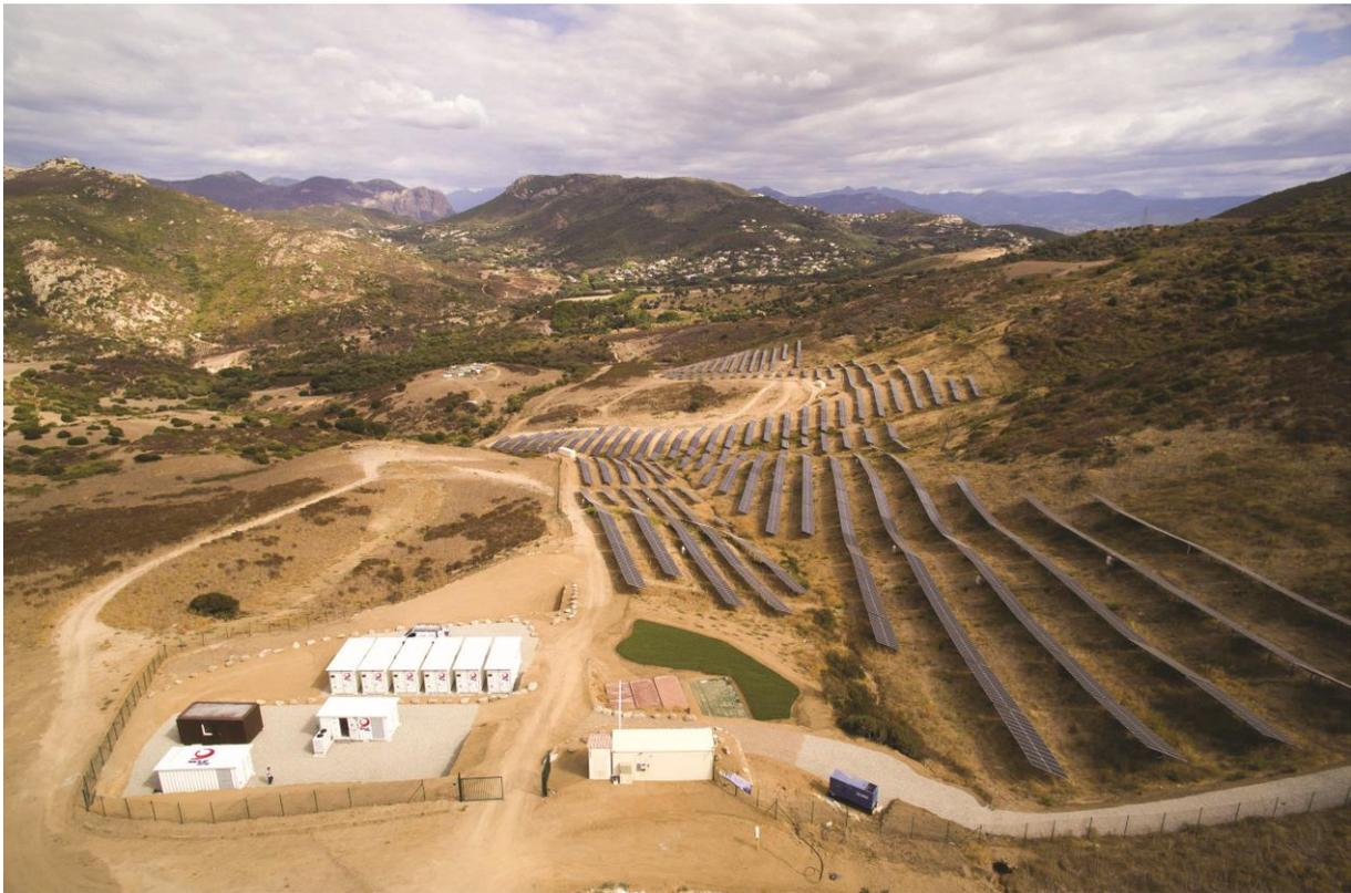
Situé à Alata, en Corse du Sud, le Smart Grid Solaire conçu et déployé par ENGIE Ineo, produit non seulement de l'énergie solaire mais permet également de stocker cette énergie en cas de forte production, ce qui garantit un approvisionnement stable et maîtrisé sur le réseau d'un jour sur l'autre.
