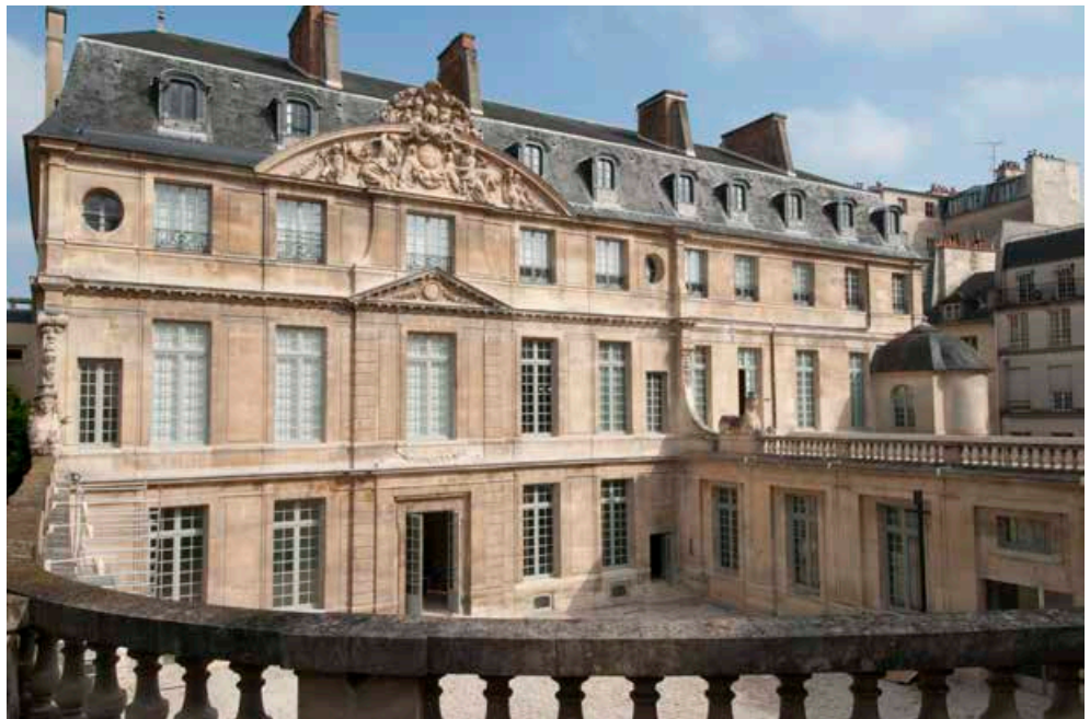
Façade sur cour de l'Hôtel Salé
