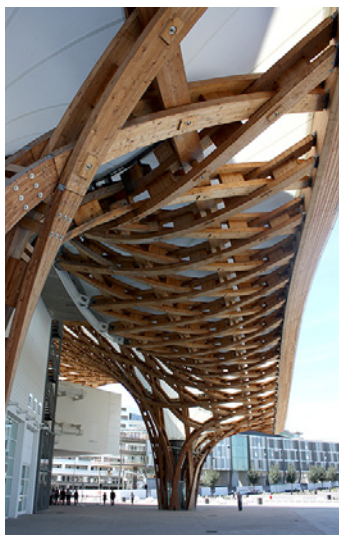
Construction du nuage de lamellé collé
