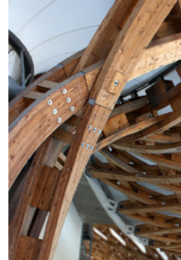
Détail d'assemblage des poutres : visserie et callage.
