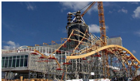
Construction du nuage de lamellé collé
