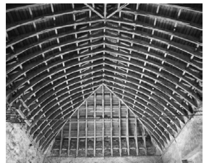
Charpente en coque de bateau
