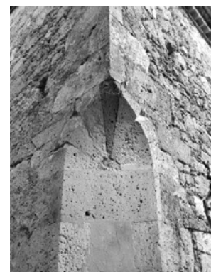
Pierres appareillées selon un axe de symétrie, construction en trompe cylindrique sur pan coupé
