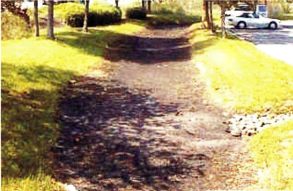
Tipikal Struktur Parit Infiltrasi
