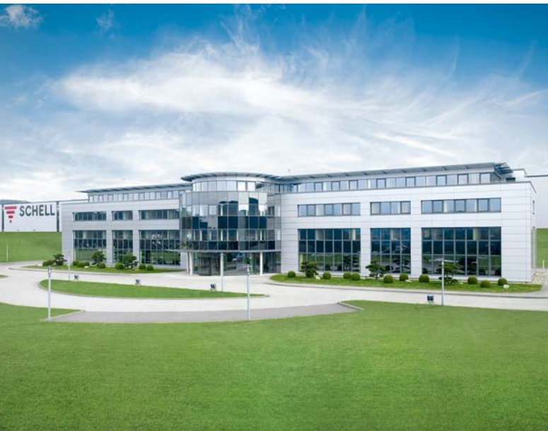
Werk 1 Produktion mit Verwaltungsgebäude und Schulungszentrum
