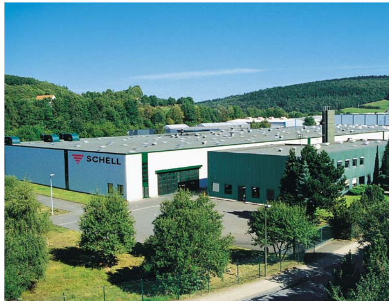
Werk 2 Produktion mit Logistikzentrum
