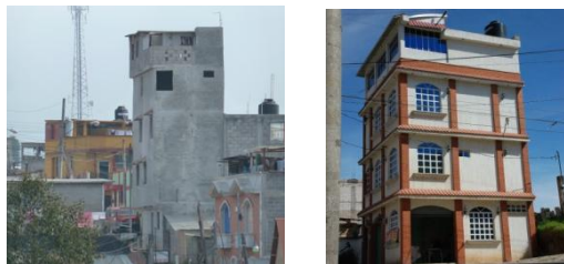
Figura 33. Ejemplos de abusos del sistema de mampostería confinada.
