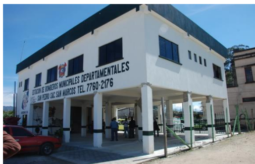
Figura 34. Estación municipal de bomberos de San Pedro Sacatepéquez, San Marcos. La estructura estaba a punto de desplomarse debido a una configuración estructural deficiente.
