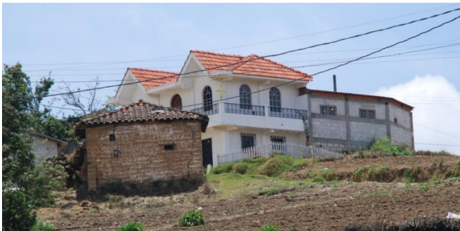
Figura 22. Construcción tradicional de adobe de limo a la izquierda; mampostería confinada de bajo costo a la derecha; en el centro, vivienda de mampostería confinada que muestra el impacto de los fondos que envían los inmigrantes a sus familias desde el exterior.
