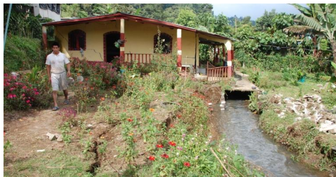
Figura 18. Esparcimiento lateral del terreno debido a la licuefacción. Pueden observarse las grietas de las casas causadas por su ubicación en la ribera del riachuelo y las mismas coinciden con los agrietamientos del suelo Municipalidad de Colomba, Coatepeque, Quetzaltenango.
