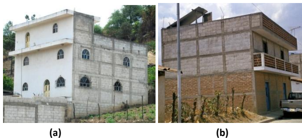
Figura 25. (a) Vivienda de mampostería confinada en el occidente de Guatemala. A diferencia de la mayoría de las construcciones en mampostería confinada alrededor del mundo, se utiliza un elemento de unión horizontal intermedio (a 1.20 metros); también se utilizan elementos de unión vertical intermedios (a 1.50 o 2.0 metros). Las losas de techo son muy comunes. (b) Vivienda en mampostería confinada en el noroeste de Guatemala. Cabe destacar nuevamente la presencia de un elemento de unión horizontal intermedio y la losa del techo.
