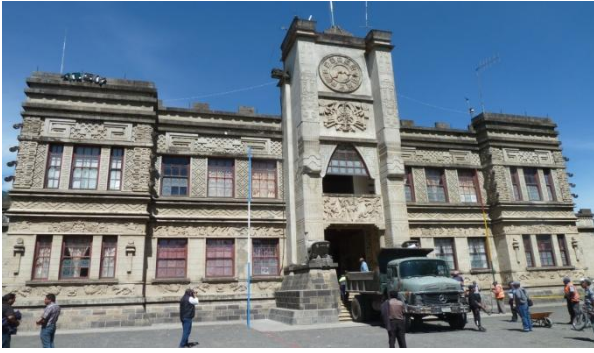
Figura 36: Palacio Maya, Municipalidad de la ciudad de San Marcos. Recientemente remodelado, el edificio sufrió serios daños y tuvo que ser desalojado.
