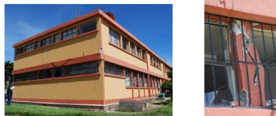
Figura 32. Efectos de columnas cortas.
