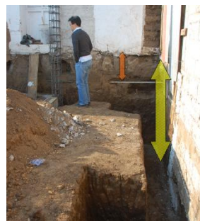
Figura 12. Profundidad de los cimientos de las casas de adobe (flecha naranja) y del suelo aluvial orgánico (flecha amarilla). San Pedro Sacatepéquez
