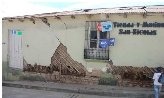
Figura 21. Mecanismos de destrucción típicos observados en las estructuras en adobe (a) y bahareque (b).
