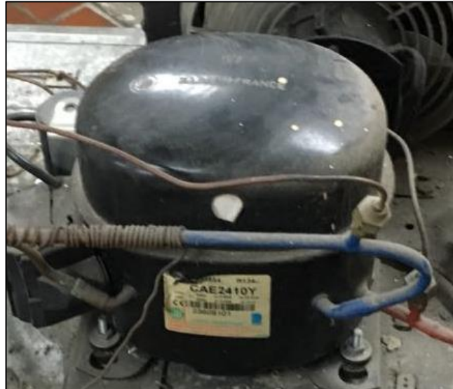
Figura 18. Compresor del prototipo de cuarto frío
