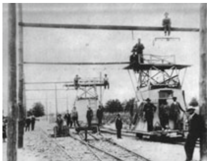
Montáž vedení troleje na trati mezi Tábořem a Bechyni
