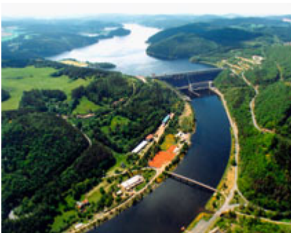
Vodní elektrárna Orlik
