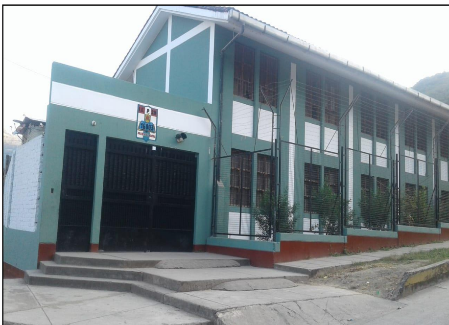
Figura 10. Colegio Miraflores Jaén.
