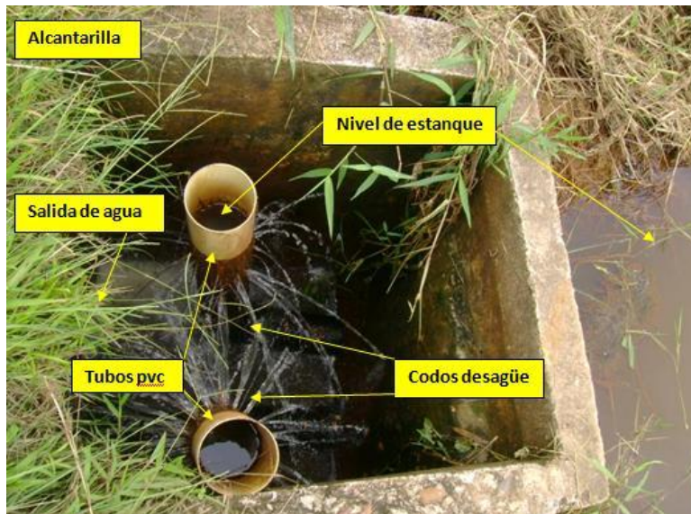
Gráfico 3. Manejo del nivel del agua con alcantarillas en los estanques.
