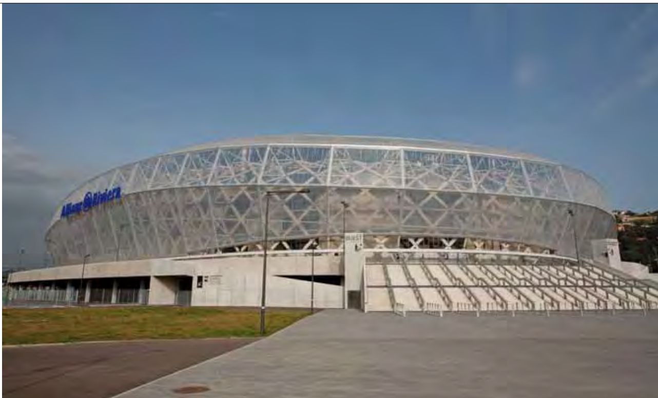
Novedosa fachada y anillo interior construidos con láminas de ETFE.
