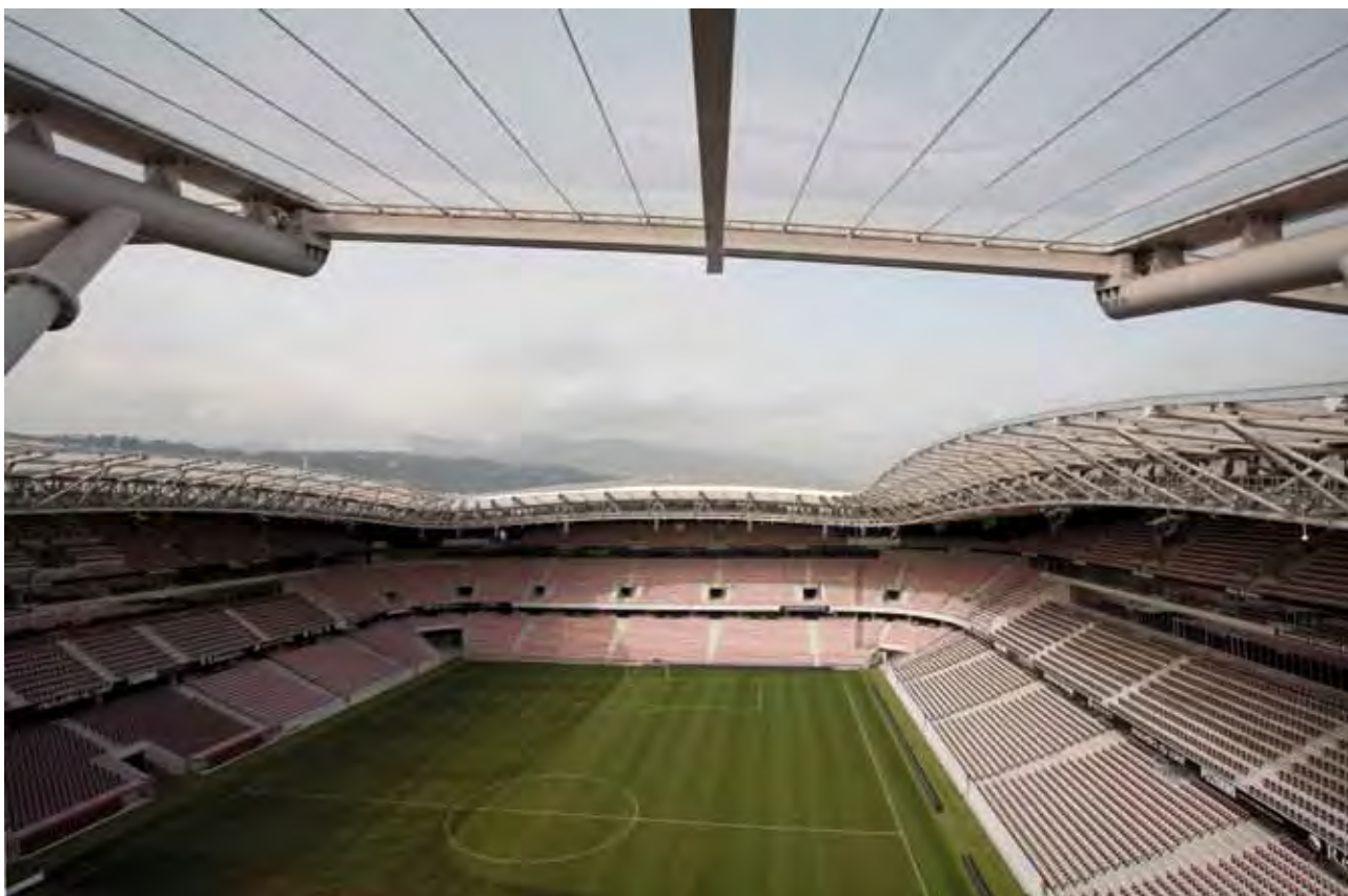
Novedosa fachada y anillo interior construidos con láminas de ETFE.
