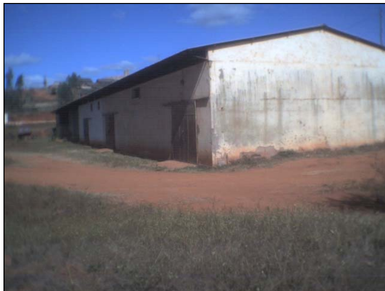
Figure n°6: Local 1 : Bâtiment de la CIRAGRI qui va servir de site pour l'unité pilote (Cliché : auteur, 2004).
