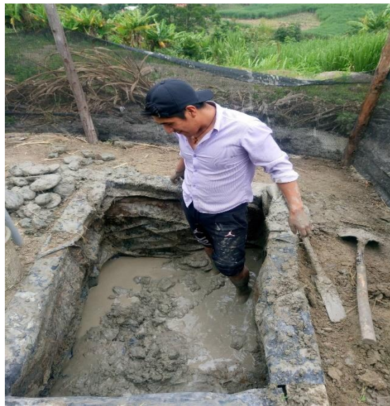
Figura 3. Eliminación del suelo saturado
