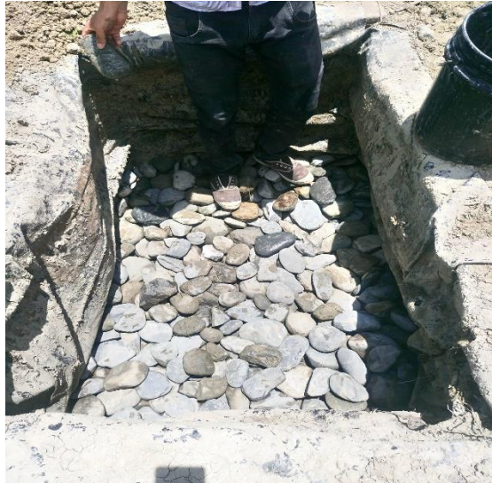
Figura 4. Colocación de piedra y grava
