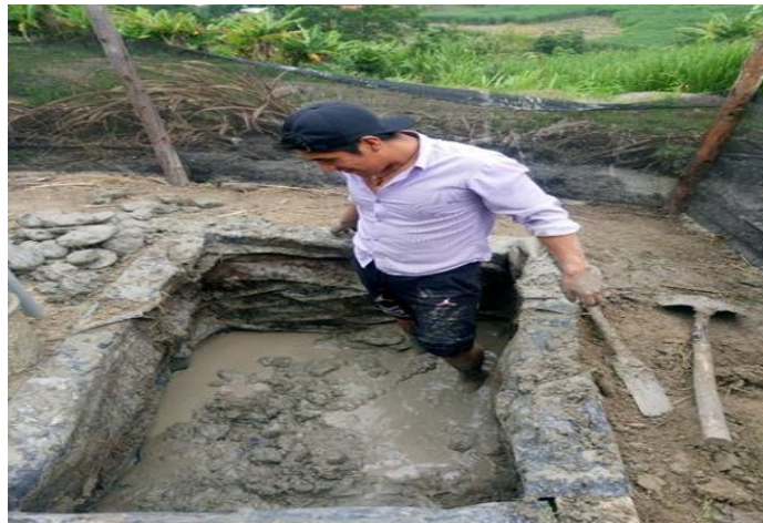
Figura 4. Restauración del lisímetro volumétrico.
