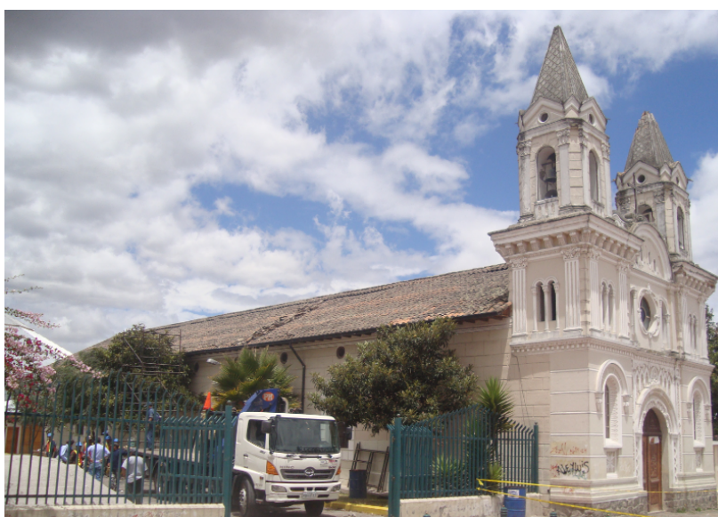
Figura 5: Iglesia de Calderón. Se observa daños moderados en la torre sur y caída de parte del tejado
