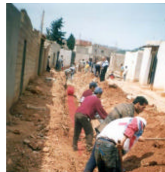
Travaux de restructuration
