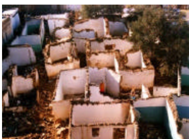
Démolition des baraques
