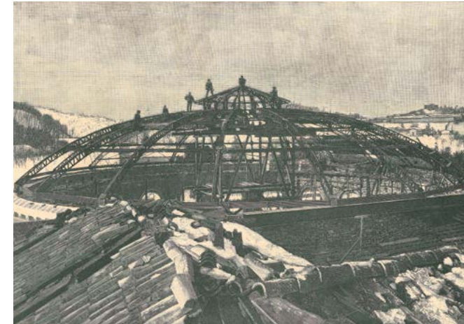
37. A. Centenari, Palazzo della Musica. Costruzione della cupola, da "L'Esposizione illustrata delle Provincie dell'Emilia in Bologna 1888", litografia (Fondo Brighetti)
