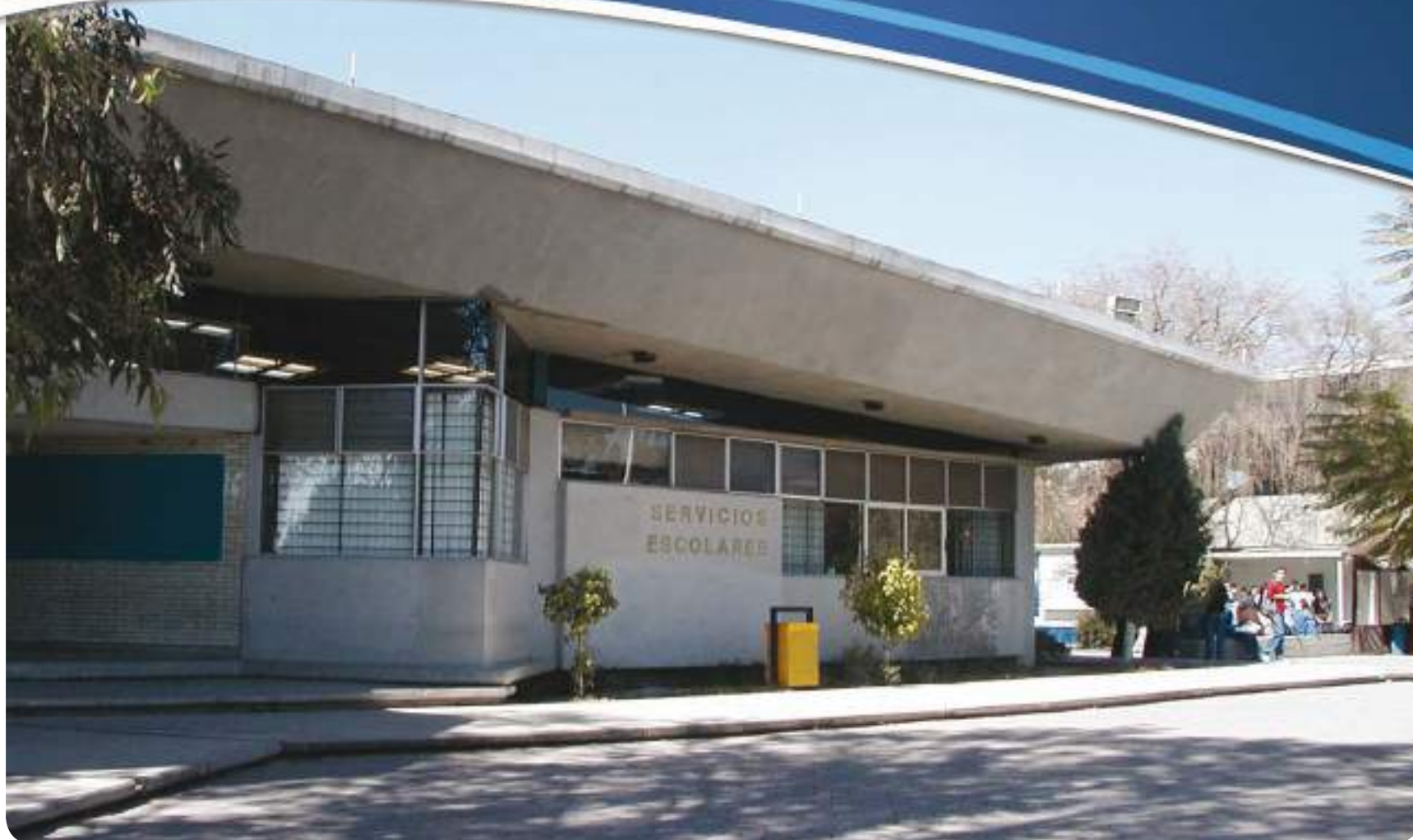
Edificio de Servicios Escolares, Campo Cuatro
