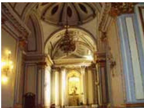
arcos torales sostiene la cúpula
