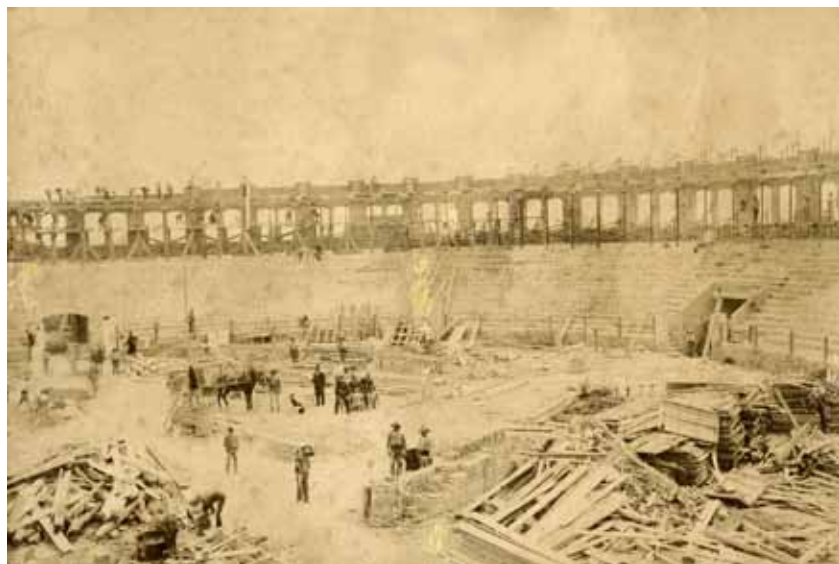
Obras de ampliación de la plaza de toros
