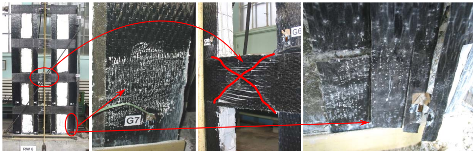
Fig. 5 RW8 wall failure modes.
