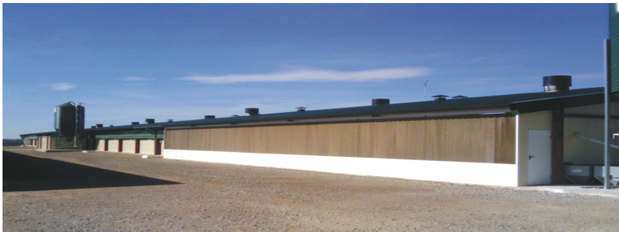
Paneles evaporativos en una nave avícola
