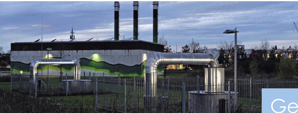
Photo © Stadtwerke München
