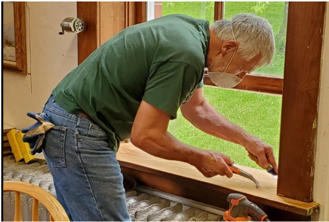
Dan Kuennen refinishing window frame
