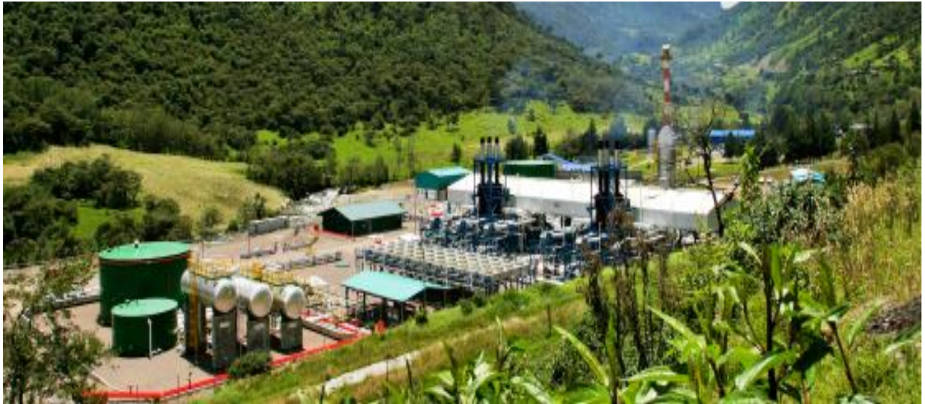
Amazonas Station, OCP Ecuador S.A. (Photo: Wärtsilä)
