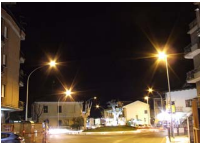
Vista da viale dell'Unione sulla rotonda della stazione
