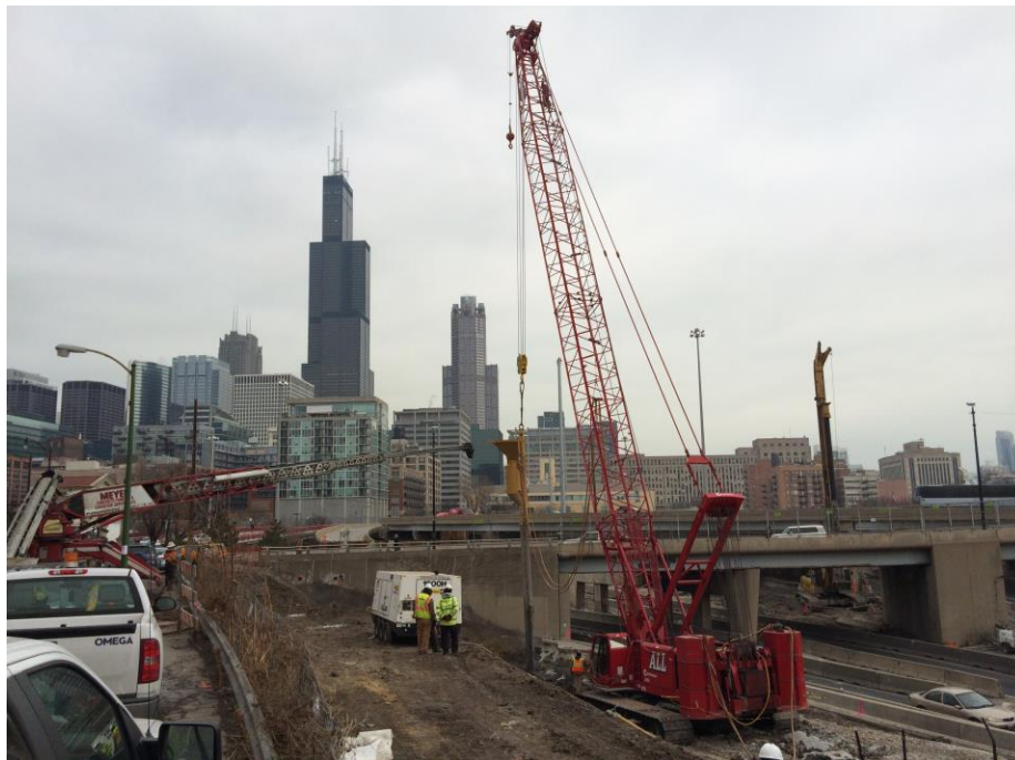
190/94 - I290 "Circle" Interchange Chicago, IL
