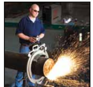
Corte de tuberías y biseles
