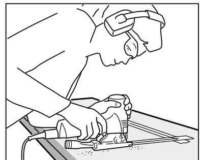
Percez maintenant un trou aux quatre coins de la ligne de coupe pour faciliter la manipulation de la scie sauteuse. Servez-vous du gabarit de coupe pour tailler l'ouverture dans le comptoir.
