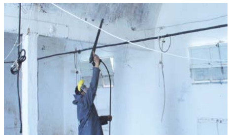
Opération de décapage du toit
