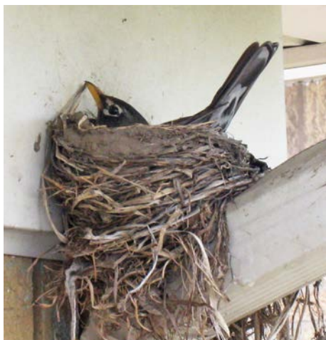
Nid d'oiseaux au plafond du bâtiment!!
