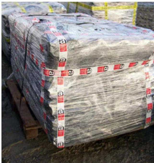
Photo 46 - Déchets d'amiante conditionnés sur palette - 2B Recyclage
