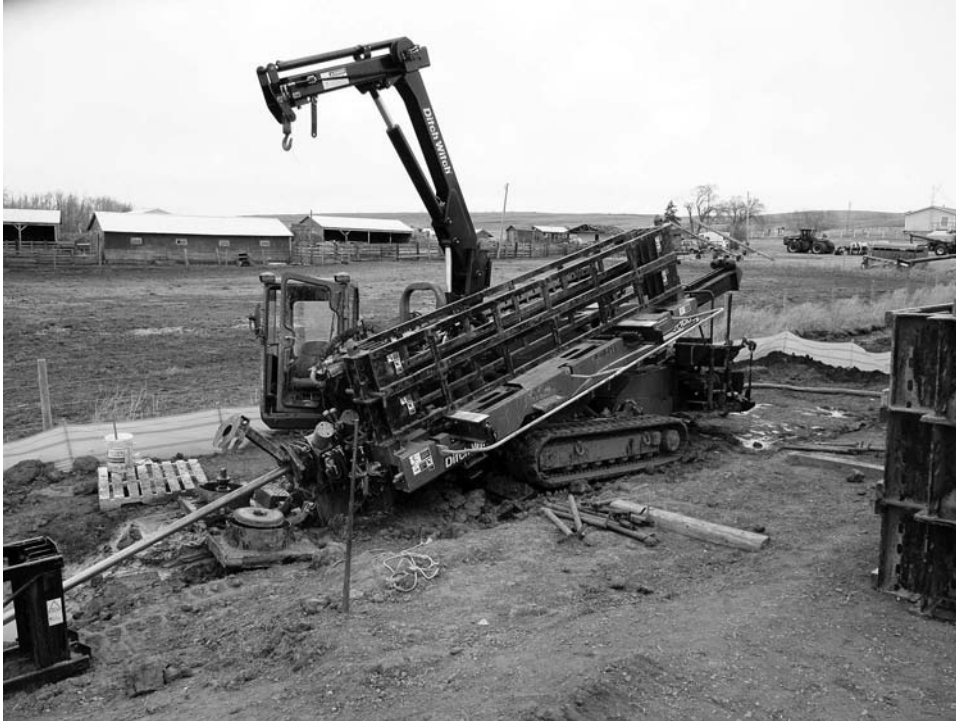
Fig. 13.6 HDD drilling rig.
